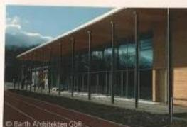
Mehrzwecknutzung Sport und Veranstaltungen. Stahlstützen, Holzbinder, Pfosten-Riegel-Fassade.
